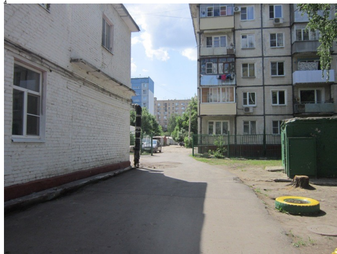
Подход к корпусу 2 со стороны ул. К.Маркса
